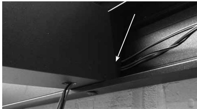
Forez un trou ou une fente de min. 9 mm de diamètre jusqu'à l'extrémité du profil ; à une distance X = distance trou à charnière = min. 10mm = distance (-2mm pour Climax (Panorama)) trou jusqu'à l'extrémité du profil d'éclairage (voir 'préparation du profil d'éclairage')
